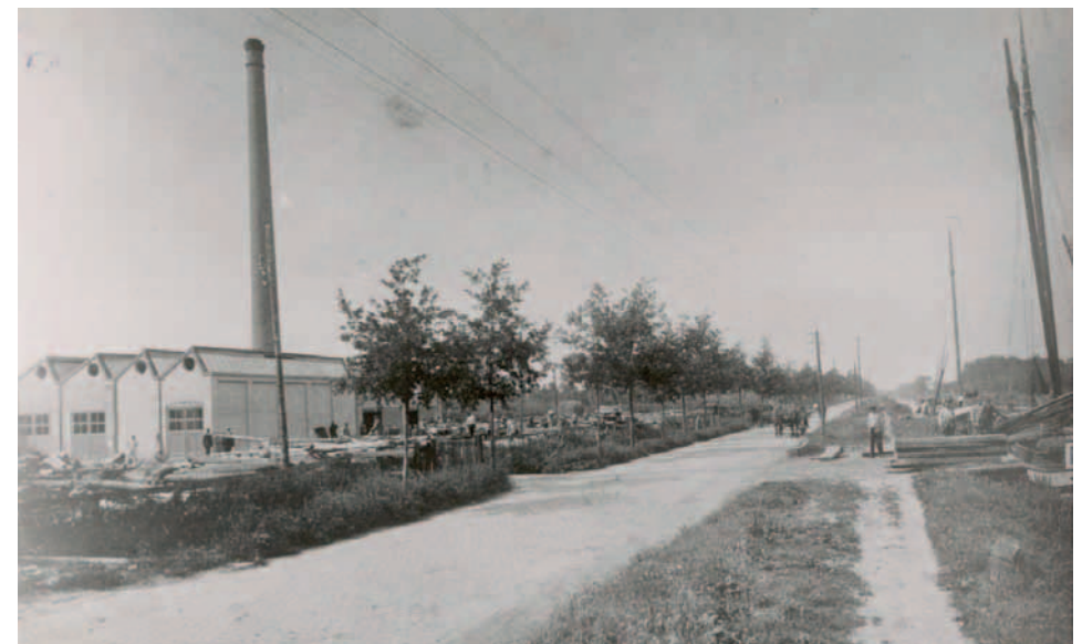
Houthandel Felix Clercx in 1916 aan de inmiddels verharde Kanaaldijk Noordwest met rechts daarnaast het jaagpad. Bron: Beeldbank Heemkundekring Helmont
